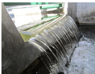
Фиг.2.2 Хидрометрични съоръжения с вертикални преливници тънка стена и остър ръб.
