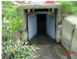
Фиг. 2.5 Примери за хидрометрични съоръжения тип „Корито на Вентури“
