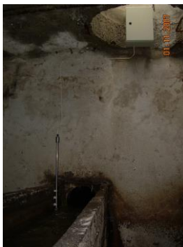
Фиг.2.1 Примери от изпълнени хидрометрични съоръжения тип „Стабилен профил”.
