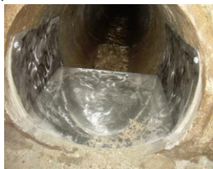
Фиг.2.3 Хидрометрични съоръжения тип „Наклонен напред преливник”
