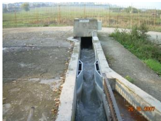
Фиг. 2.5 Примери за хидрометрични съоръжения тип „Корито на Вентури“
