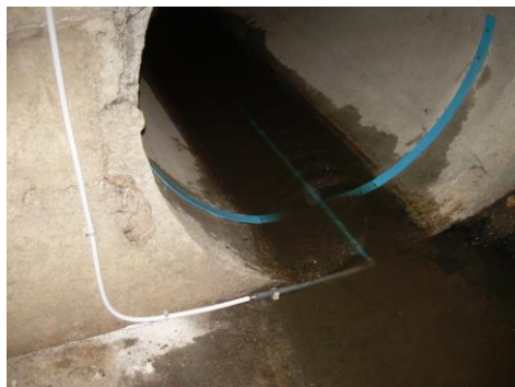
Фиг.2.1 Примери от изпълнени хидрометрични съоръжения тип „Стабилен профил”.
