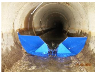
Фиг. 2.4 Хидрометрични съоръжения тип „Комбиниран наклонен напред преливник“
