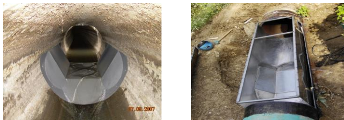
Фиг. 2.6 Примери за хидрометрични съоръжения тип „Палмер – Боулъс“
