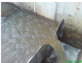
Фиг.2.2 Хидрометрични съоръжения с вертикални преливници тънка стена и остър ръб.
