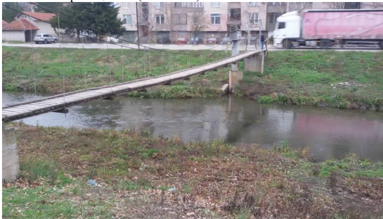
Фиг.3.1.5 Мерителен мост на хидрометрична станция №17850 на р. Скът (десен приток на р. Огоста) в гр. Мизия.
