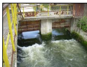
Фигура 1. Измервателен преливник
