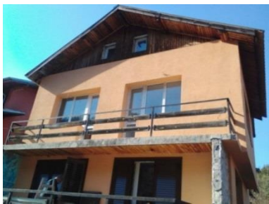
Ремонт Велинград (не е завършен)
