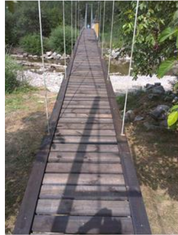
Фиг.9.7.1. Ремонти по мерилни мостове: а) ремонтиран релсов мост на ХМС 16450; б) ремонтиран въжен мост на ХМС 22650 с. Черни Осъм
