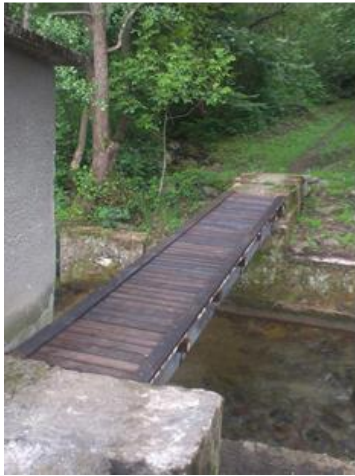
Фиг.9.7.1. Ремонти по мерилни мостове: а) ремонтиран релсов мост на ХМС 16450; б) ремонтиран въжен мост на ХМС 22650 с. Черни Осъм
