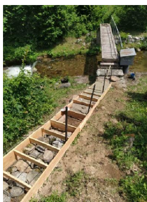
Сн. 1. Кофражни и бетонови работи по направа на стълби
