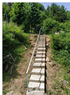
Сн. 2. Изградена стоманобетонова стълба
