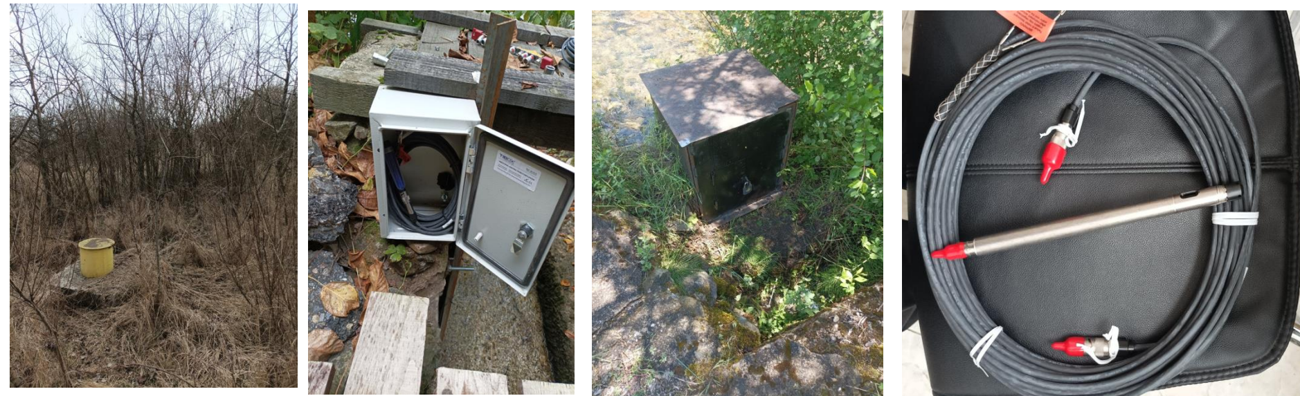
Фиг.2 Монтаж на устройство за събиране на данни от Хидронаблюдателен Геоложки Наблюдателен Пункт – (ХГНП)
